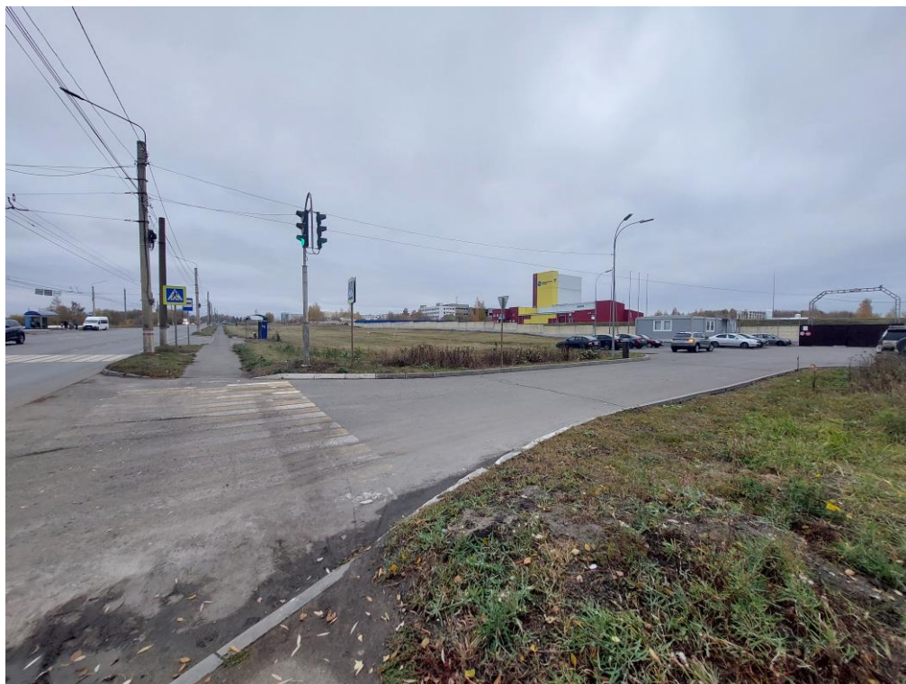
Фото 2. Радиусы закругления и примыкание. Пешеходный переход через примыкание. Поперечные трещины в асфальтовом покрытии
